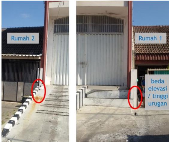
Gambar 2. Beda elevasi rumah baru dan lama (Rumah 1 dan Rumah 2)
