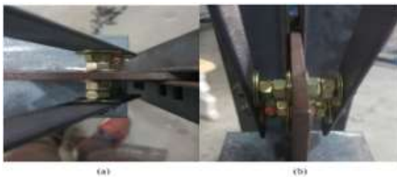
Gambar 5. Sambungan Baut Bracing ABS
