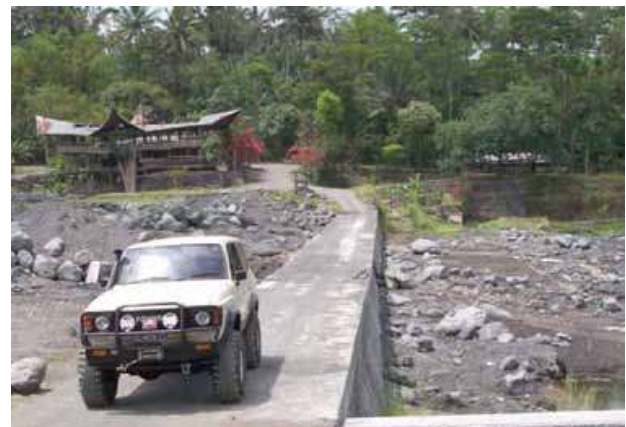
Gambar 1. Bangunan Sabo Untuk Jalan Penyeberangan
